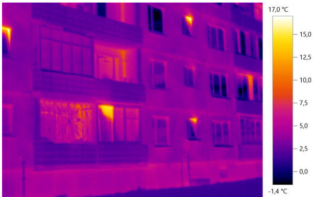
10. att. Ēkas fasāde
