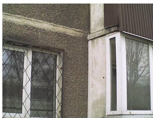
3.attēls. Balkona/ārsienas termiskais tilts, siltuma zudumi caur loga rāmja/stiklojuma savienojuma vietu
